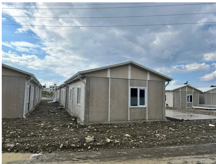
Φωτογραφία από τους οικίσκους για την κάλυψη αναγκών στέγασης των σεισμοπαθών στην περιοχή της Αντιόχειας.
